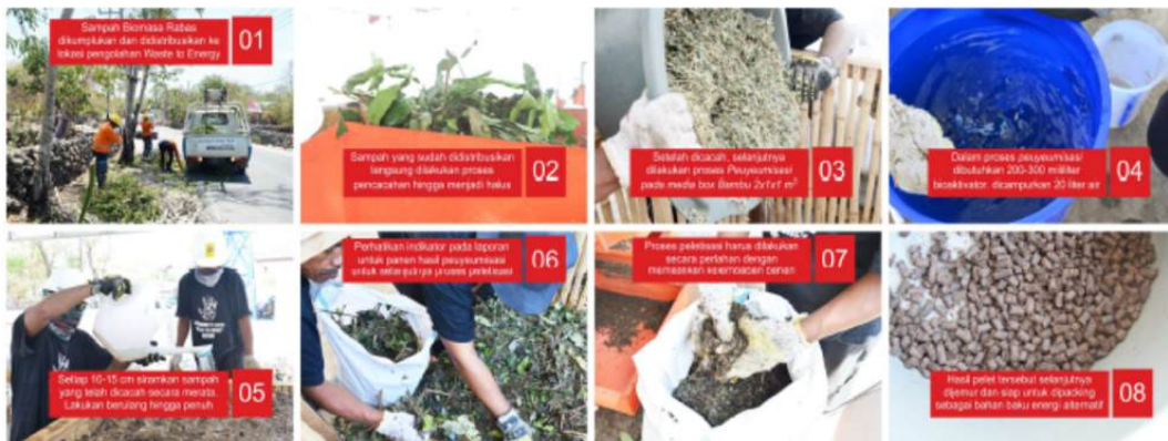
Gambar 2. Proses Pengolahan Biomassa/Residu Biomassa Menjadi Bahan Bakar
