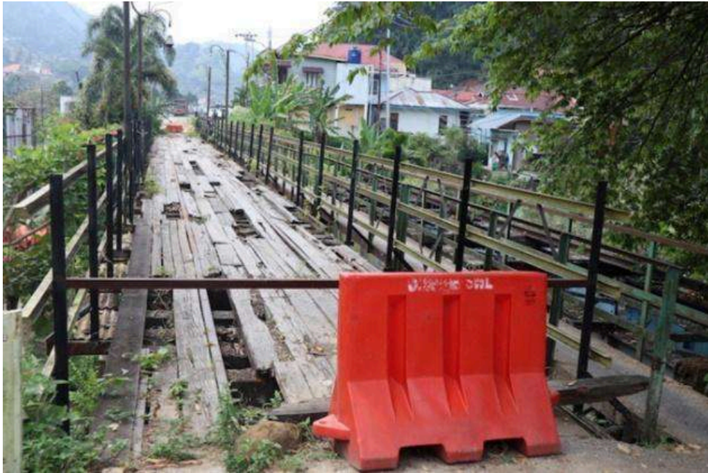
Foto Jembatan Saringan sebelum pemeliharaan (2021)
