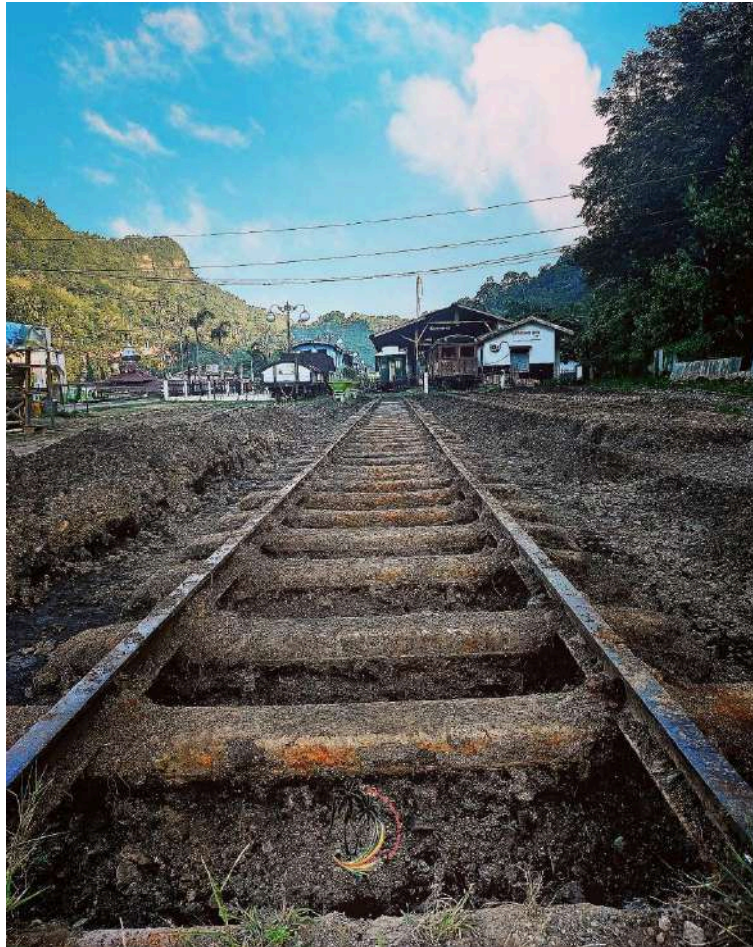
Foto saat pekerjaan reaktivasi (2022)
