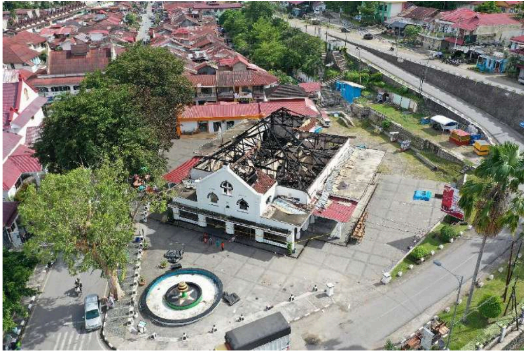
Foto Udara Gedung Pusat Kebudayaan (Societeit Glück auf) 4 November 2022
