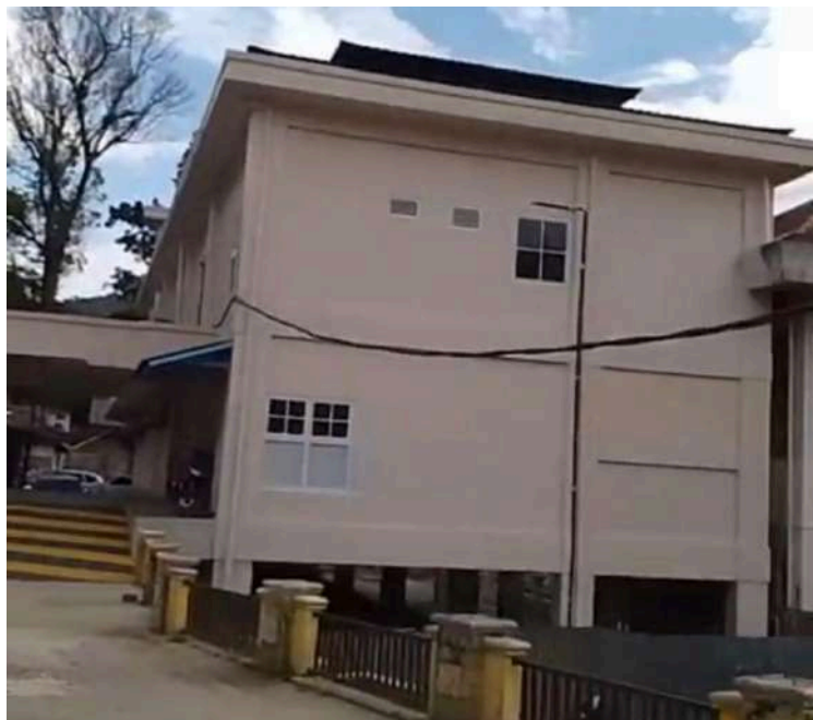
Infill Building Gedung Instalasi Gawat Darurat dan Radiologi RSUD Sawahlunto
