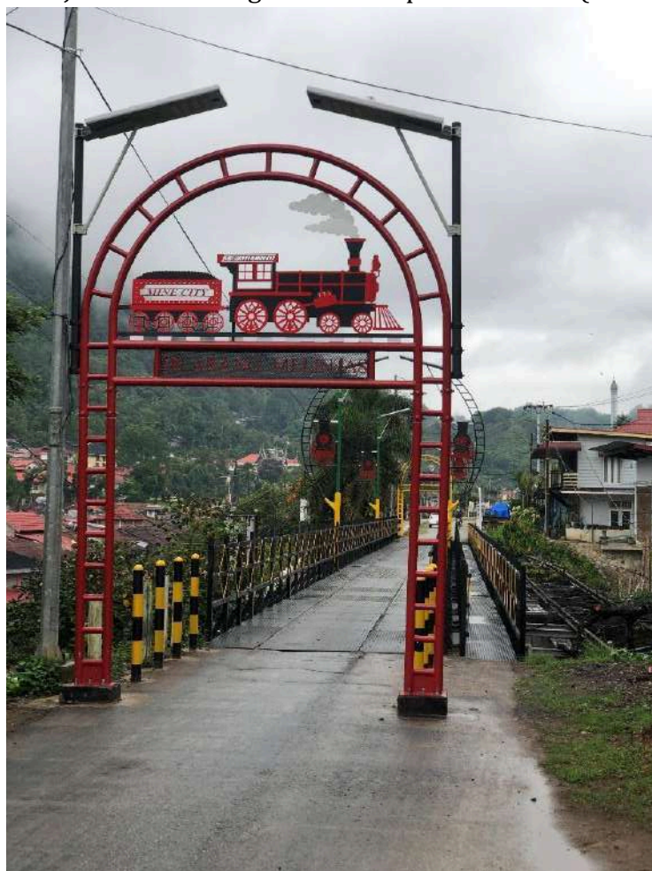
Foto Jembatan Saringan setelah pemeliharaan (2022)
