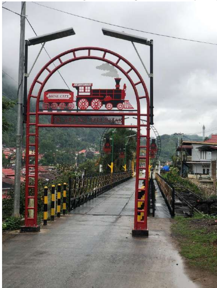
Foto Jembatan Saringan setelah pemeliharaan (2022)
