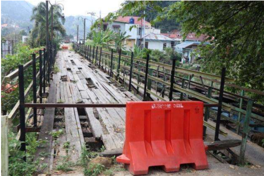
Foto Jembatan Saringan sebelum pemeliharaan (2021)
